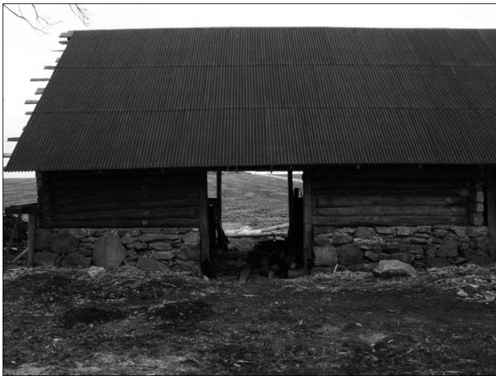
Lauda põhjasein pärast taastamist: hoone fassaad on näiliselt säilinud, selle tervikut on lõunaseina ja katusetarindi osas põhjalikult muudetud.
