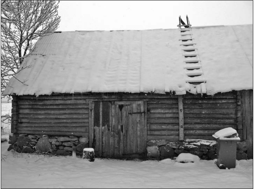
Pritsu talu lauda põhjasein enne demonteerimist.
