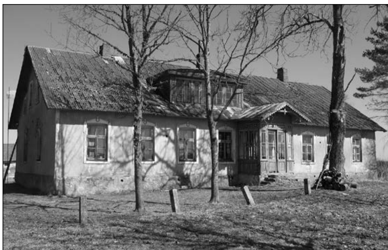
4: 1896. a tüüpprojekti järgi ehitatud Esna vallamaja on tähelepanuväärne oma rikkalike kaunistuselementide poolest: krohvitud aknapiirded ja liseenid, sibulkupli motiivi meenutavad akende lamekarniisid, otsaviilude alused lõikelised konsoolid ning dekoratiivne klaasveranda. Foto M. Tamjärv, 2006.
