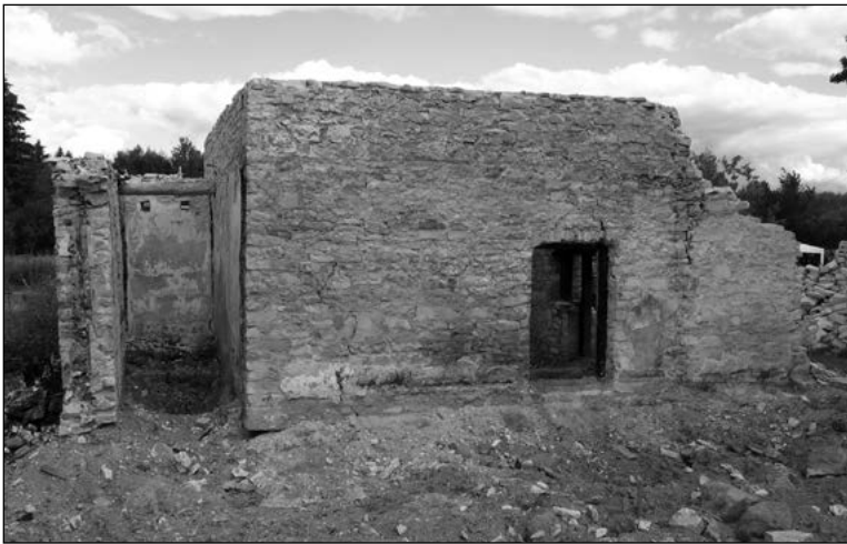
2: 2004. a tulekahju paljastas Sillaotsa rehemaja sisemuses peituvat haruldust – päekivist rehetoa. Täna on hoone uuel kujul üles ehitatud. Foto H. Talving, 2006.
